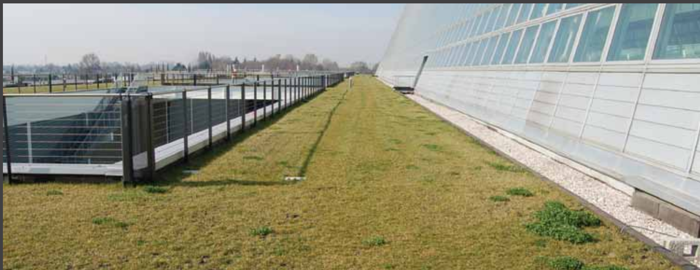
fig. 3) Aree verdi carrabili completate ed utilizzate dagli automezzi di soccorso VVFF. Finished green area accessible to emergency vehicles.
