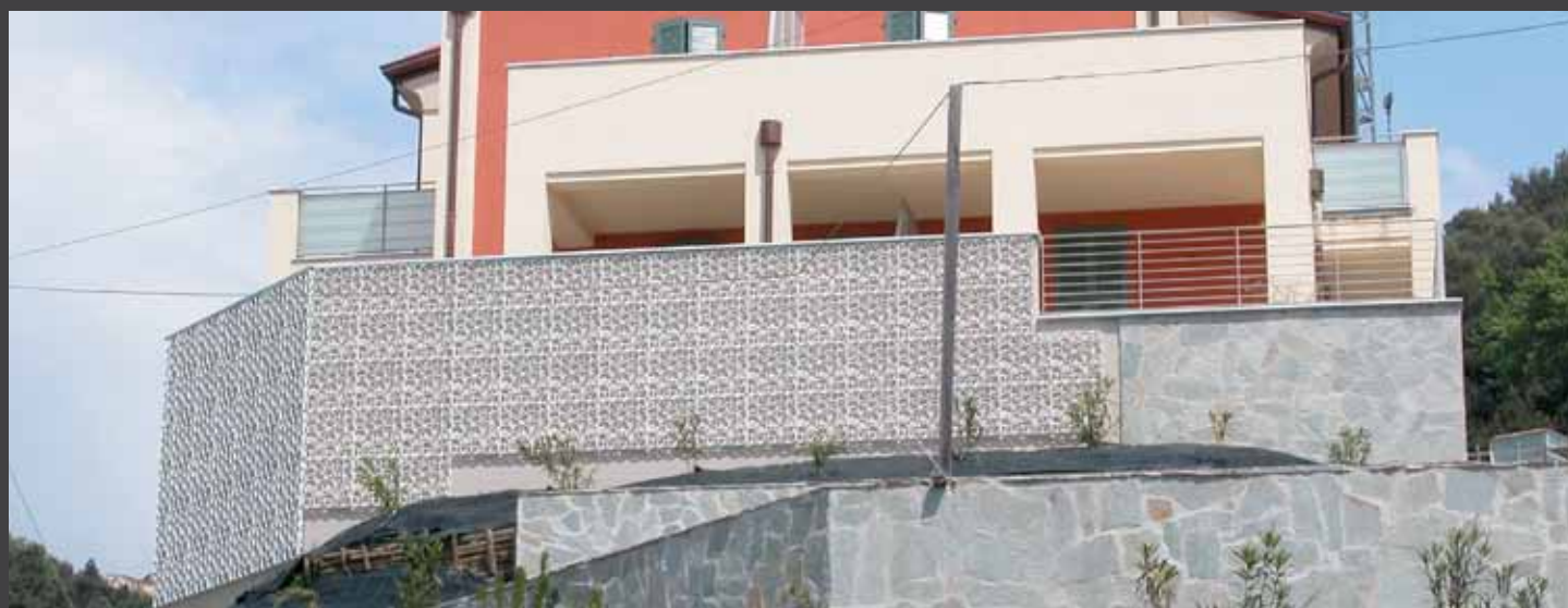
fig. 1) Applicazione su parete esterna della griglia WALL-Y® - Villaggio Turistico - Muggiano, La Spezia. WALL-Y® on an outside roof - Resort, Muggiano, La Spezia, Italy.
