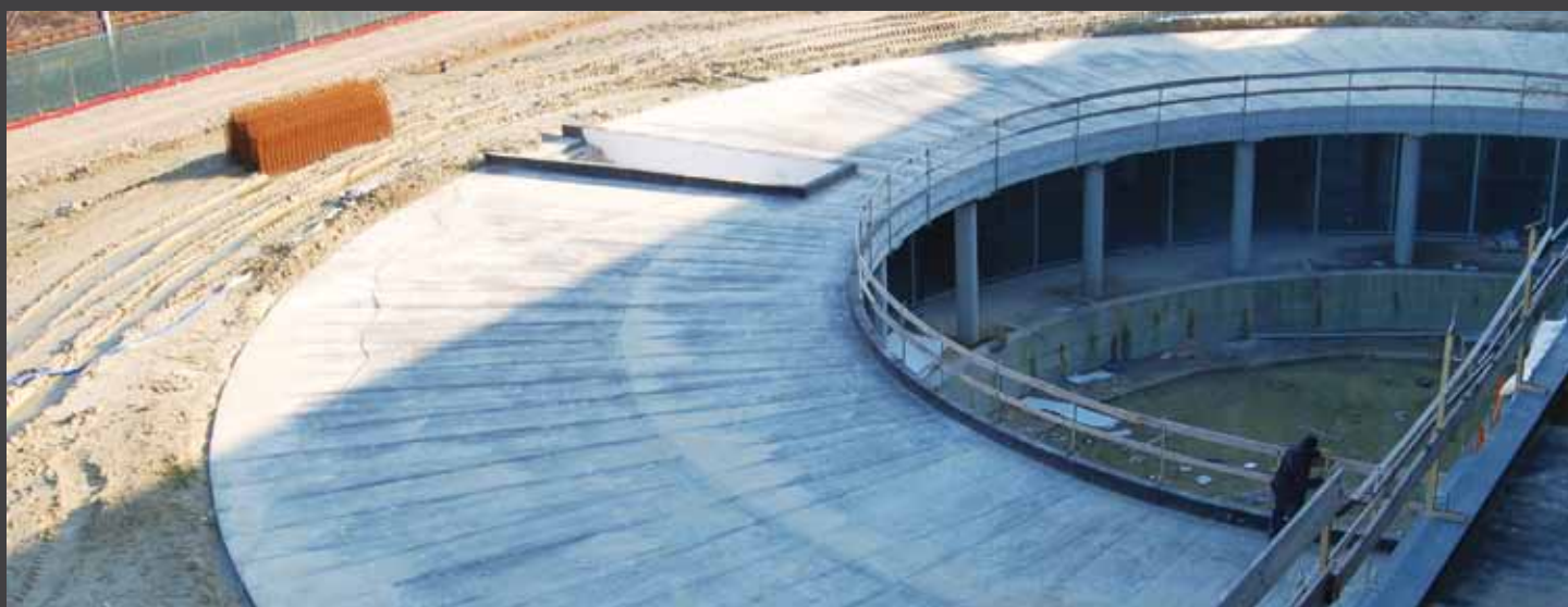
fig. 1) Preparazione della superficie per realizzazione di giardino pensile - Fondazione Banca degli Occhi del Veneto - Mestre - VE. Structure that will be covered by a green roof - Fondazione Banca degli Occhi del Veneto, Mestre, Italy.
