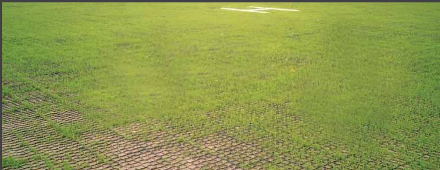
fig. 1) Area di atterraggio elicotteri realizzata con RUNFLOOR® GREEN in fase di inerbimento - Aeroporto Turistico del Cinquale - Massa Carrara. Helicopter landing pad created with RUNFLOOR® GREEN, first grass growth - Cinquale tourist airport, Massa Carrara, Italy.
