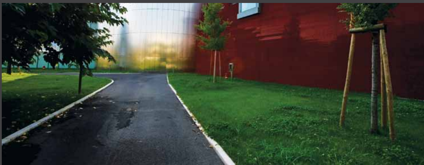
fig. 1) Aree verdi carrabili di accesso realizzate con GEOFLO® - Parco Scientifico Tecnologico "Kilometro Rosso" - BG. Green carpark created with GEOFLO® - Kilometro Rosso Science & Technology Park - Bergamo, Italy.
