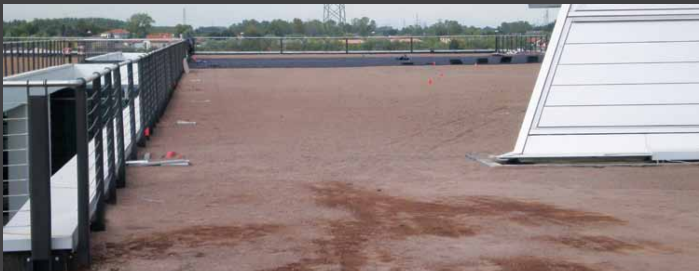
fig. 1) Realizzazione dello strato drenante in lapillo vulcanico con granulometria 5-20 mm - Ospedale dell'Angelo, Mestre - VE. Volcanic lapillo substrate with grain size 5-20 mm - "Ospedale dell'Angelo" hospital, Mestre, Italy.
