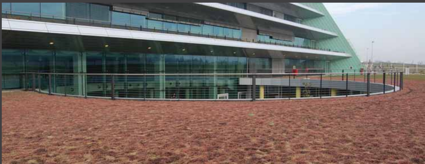
fig. 3) Giardino pensile estensivo realizzato con DRAINROOF - Fondazione Banca degli Occhi del Veneto - Mestre - VE. Green roof created with DRAINROOF - Fondazione Banca degli Occhi del Veneto, Mestre, Italy.
