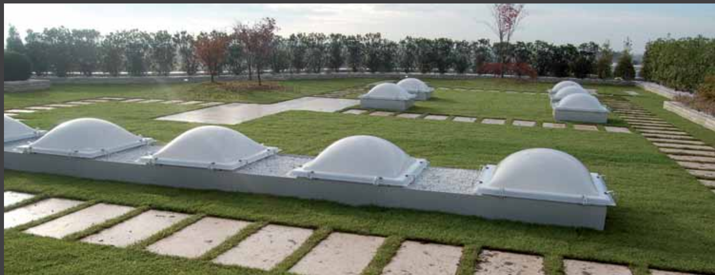
fig. 2) Giardino pensile estensivo realizzato con DRAINROOF. Green roof created with DRAINROOF.
