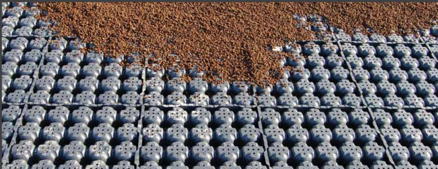
fig. 2) Posa di DRAINROOF e riempimento con lapillo vulcanico. Installation of DRAINROOF and volcanic lapillo covering.
