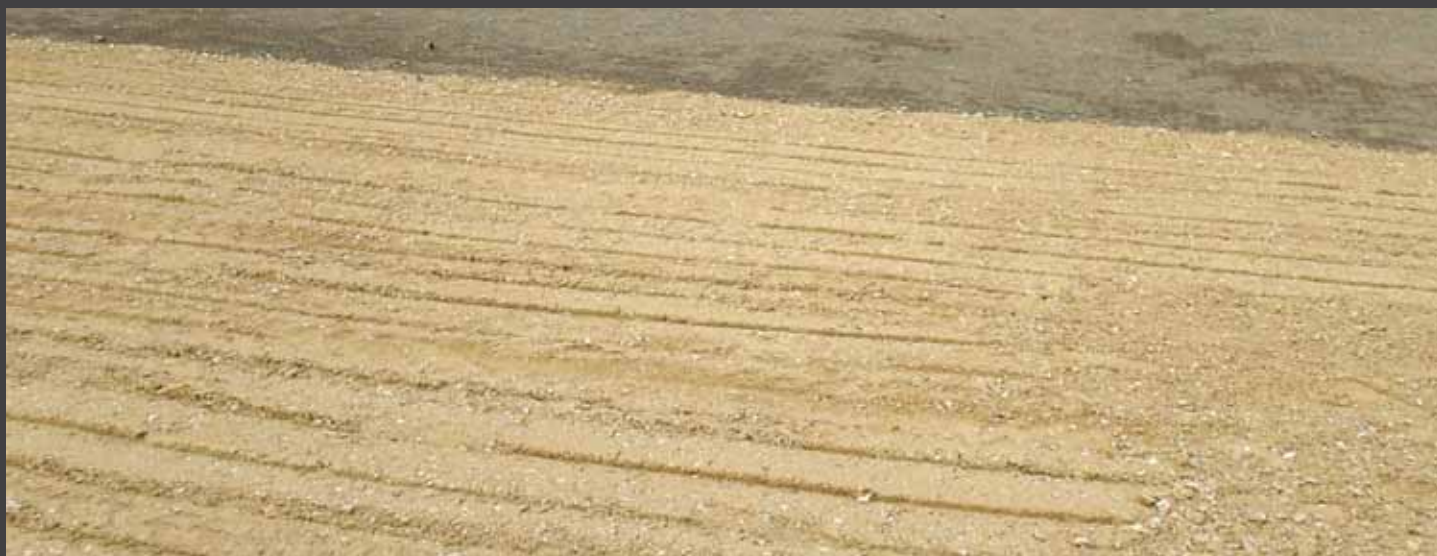
fig. 1) Realizzazione di orizzonte drenante di un parcheggio - Ristorante Alla Vigna - Torreglia - PD. Draining® subbase for a carpark - Ristorante Alla Vigna, Torreglia, Italy.
