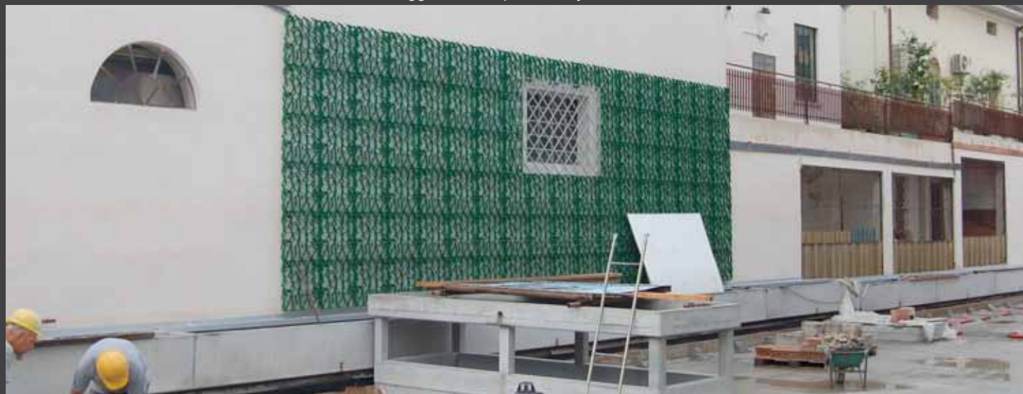
fig. 3) Realizzazione di verde verticale con WALL-Y® in struttura civile. Green wall with WALL-Y®.
