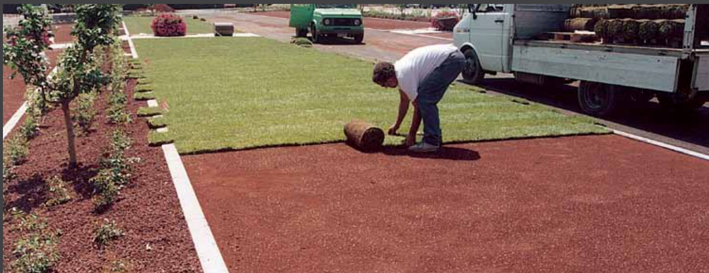
fig. 1) Realizzazione del piano di posa con lapillo vulcanico e successiva stesura del prato a rotolo - Parcheggio Viest Hotel - Vicenza. Preparation of the lawn with a volcanic lapillo subgrade and grass rolls - Viest Hotel carpark, Vicenza, Italy.
