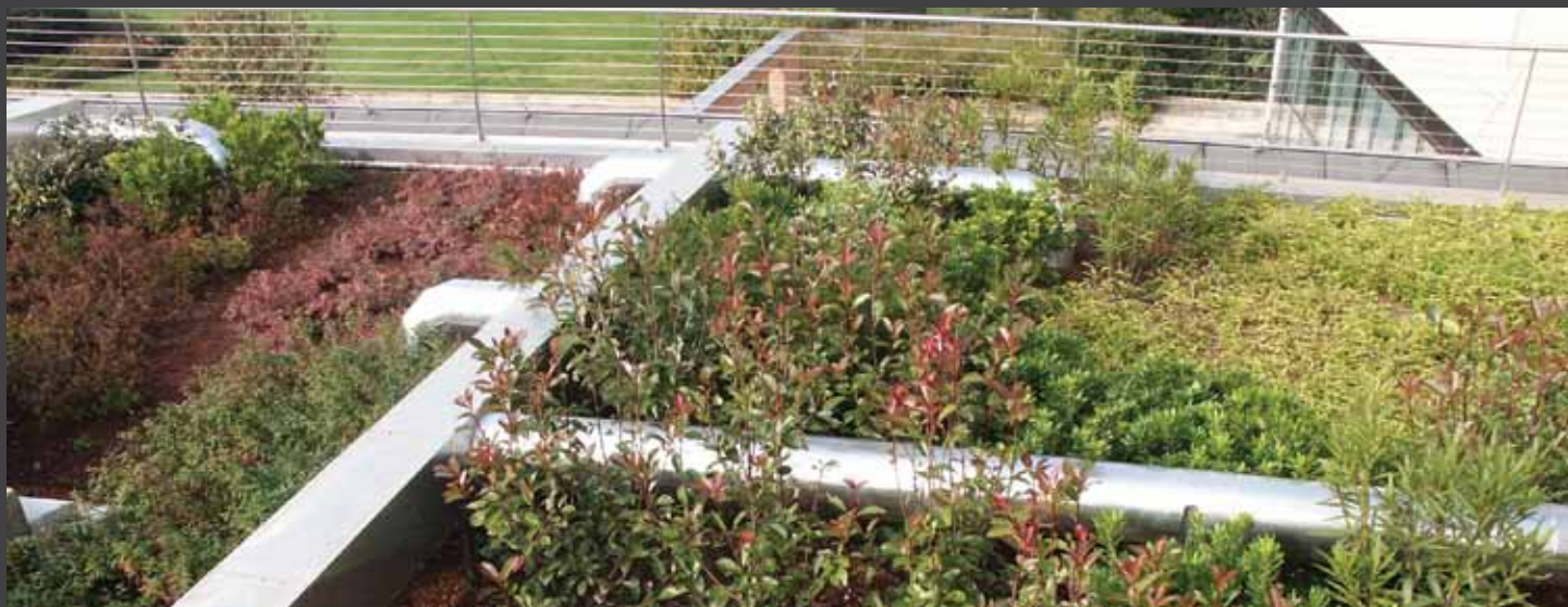
fig. 2) Giardino pensile estensivo realizzato con DRAINROOF - Viest Hotel - Vicenza. Green roof created with DRAINROOF - Viest Hotel, Vicenza, Italy.
