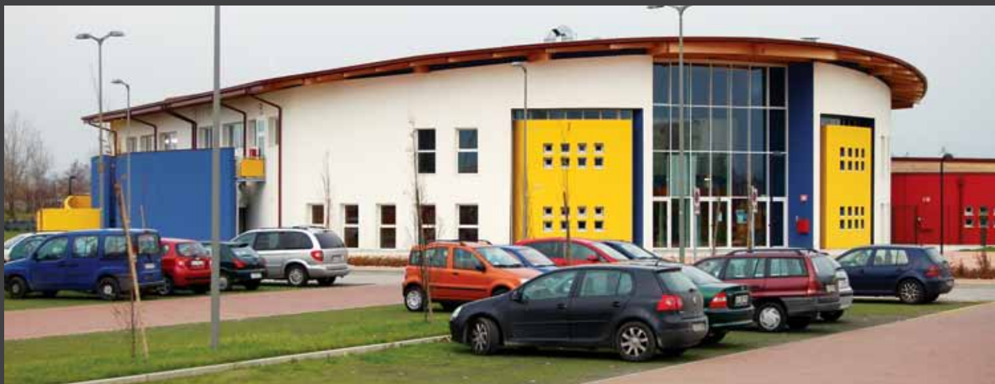
fig. 1) Realizzazione di un parcheggio con SALVAVERDE® - Villaggio Sportivo "Le Magnolie" - Piazzola sul Brenta - PD. Carpark with SALVAVERDE® - Sport Village "Le Magnolie", Piazzola sul Brenta, Italy.
