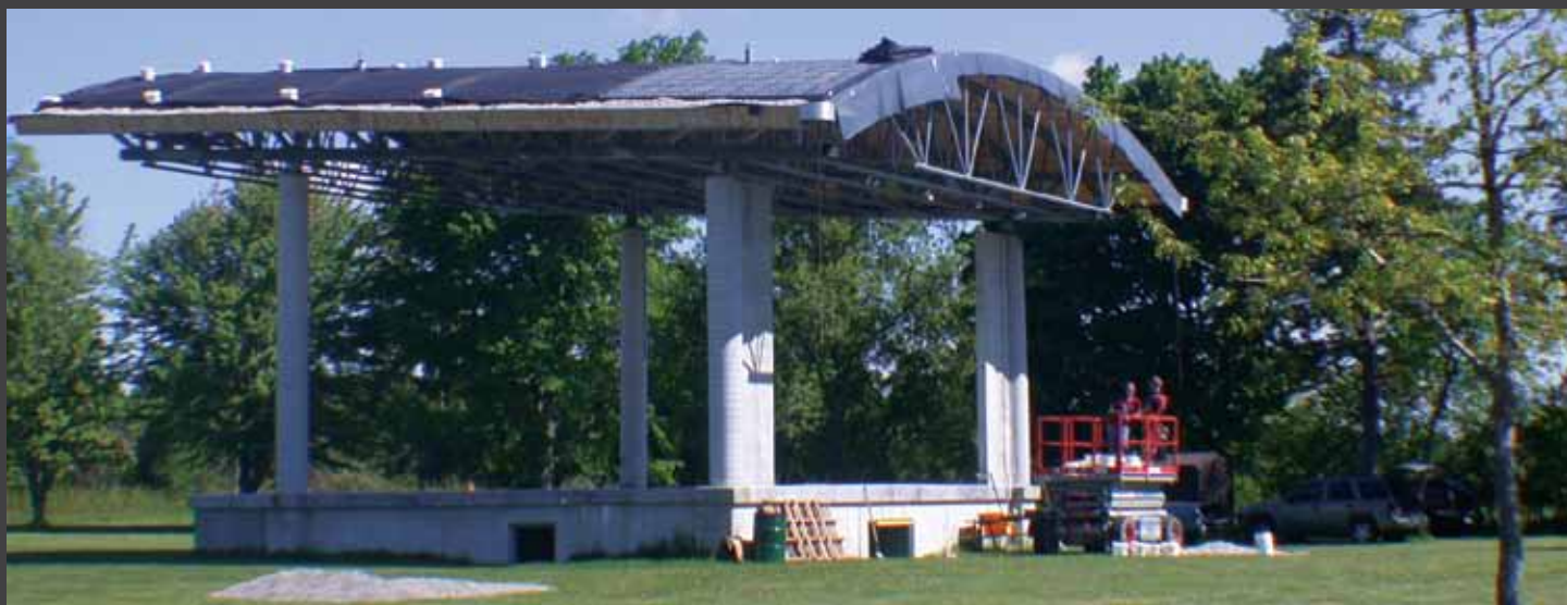
fig. 1) Giardino pensile estensivo realizzato con DRAINROOF su tetto curvo - Toronto - Canada. Extensive green roof created with DRAINROOF over a curved surface - Toronto, Ontario, Canada.
