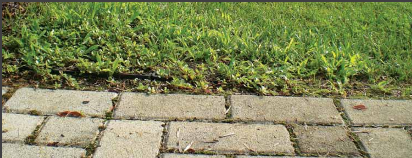
fig. 2) Particolare della griglia GEOFLO ® inerbita a ridosso del vialetto pedonale. Detail of the fully grown lawn with GEOFLO ® close to a paved walkway.
