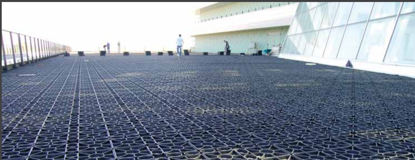
fig. 2) Posa della griglia GEOFLO® su tutta l'area del passaggio carrabile. Installation of GEOFLO® over the whole surface accessible to vehicles.
