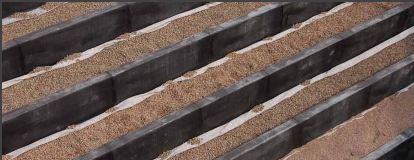
fig. 1) Giardino pensile "a terrazze" realizzato con DRAINROOF - Fondazione Banca degli Occhi del Veneto - Mestre - VE. Terraced green roof created with DRAINROOF - Fondazione Banca degli Occhi del Veneto, Mestre, Italy.
