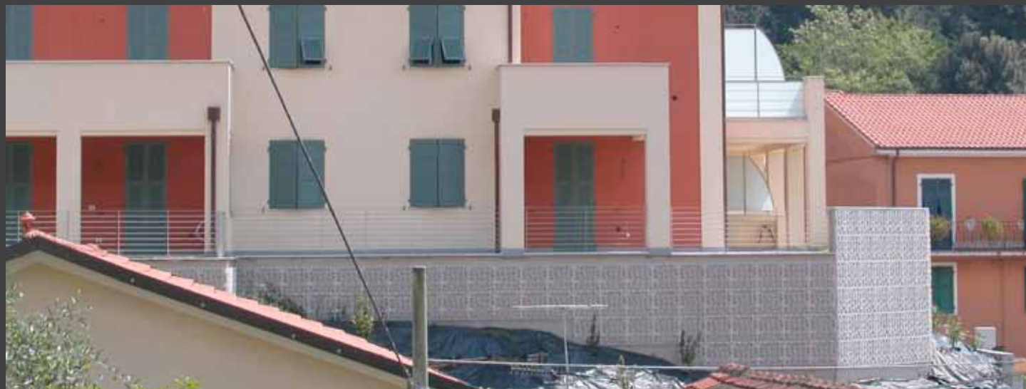
fig. 2) Vista laterale parete WALL-Y® - Villaggio Turistico - Muggiano, La Spezia. Side view of the wall with WALL-Y® - Resort, Muggiano, La Spezia, Italy.
