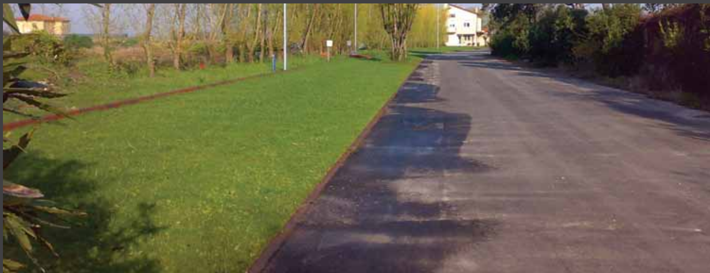
fig. 3) Parcheggio finito con completa integrazione della griglia SALVAVERDE®. Finished carpark, SALVAVERDE® is completely integrated in the lawn.
