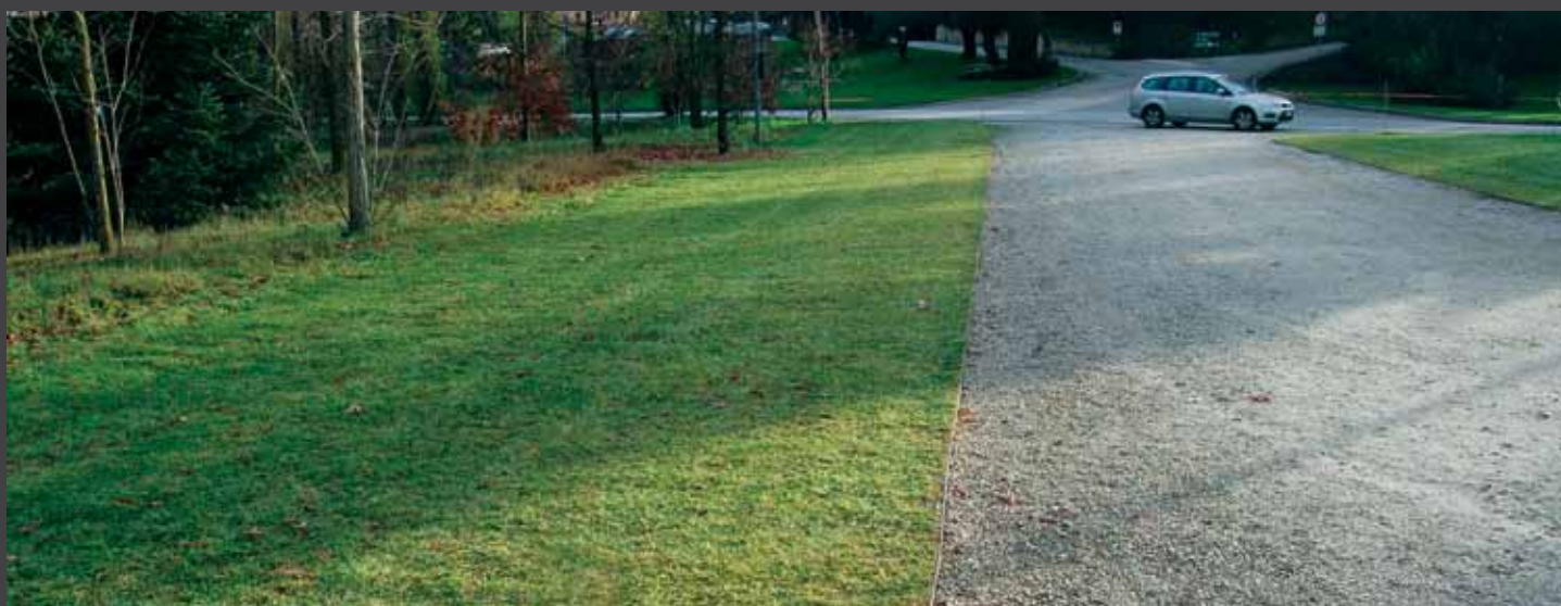
fig. 1) Realizzazione di un parcheggio clienti con GEOFLO® - Vivaio Dalle Rive - Zugliano - VI. Creation of a customer carpark with GEOFLO® (R) - Dalle Rive nursery, Zugliano, Italy.
